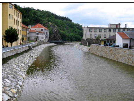
c. regulovaná řeka v betonovém korytě
