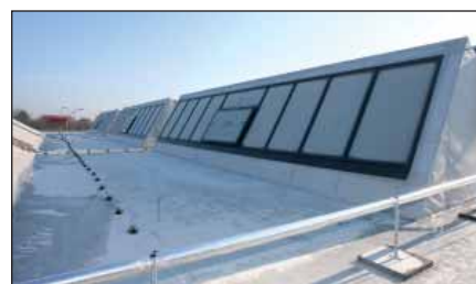
▲ Tzv. šedové světlíky umožňují regulaci umělého osvětlení.
