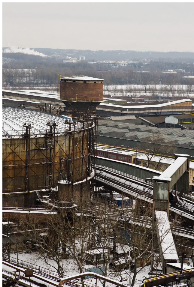
Foto 8: Plynojem vysokopecního plynu (Jiří Zerzoň)
