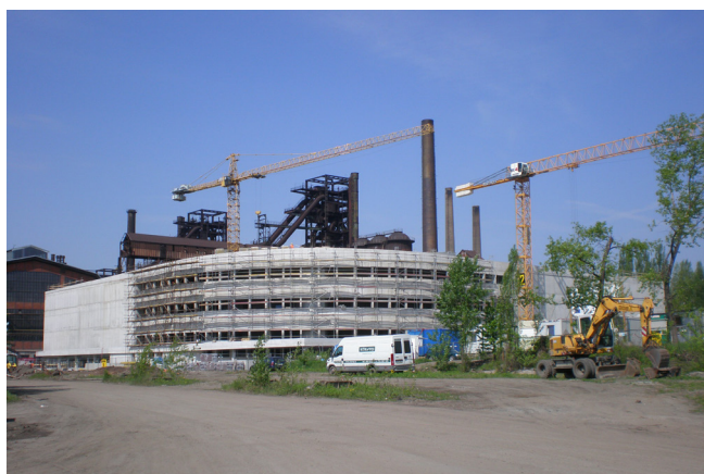
Foto 15: Výstavba Science and Technology Centra (VÍTKOVICE MACHINERY GROUP)
