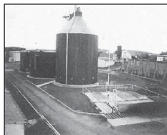
Foto 1: Zemědělská bioplynová stanice Trhový Štěpánov
