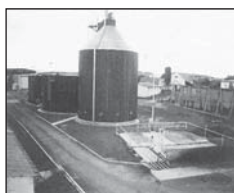
Foto 1: Zemědělská bioplynová stanice Trhový Štěpánov
