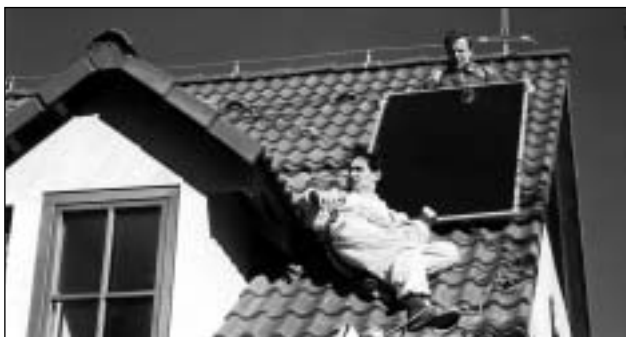
Obnovitelné zdroje přinášejí značné množství pracovních míst. Montáž slunečních kolektorů na střeche rodinného domu, Praha.
