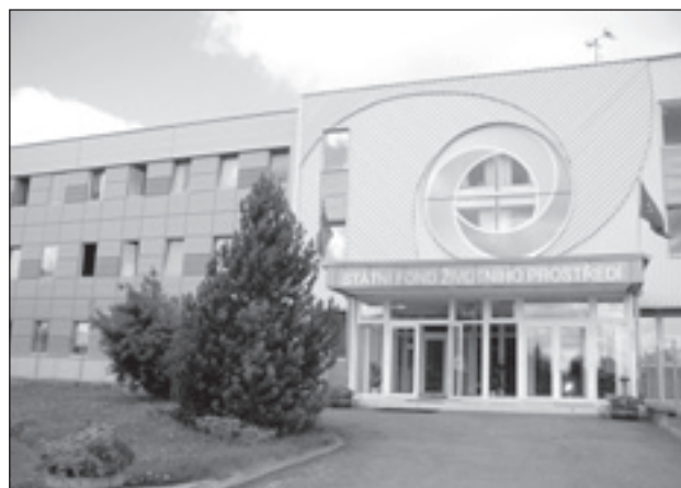
Budova SFŽP v novém kabátě.
