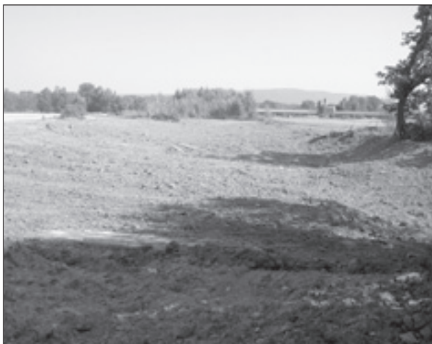
Stav po odvezení sádrovce
