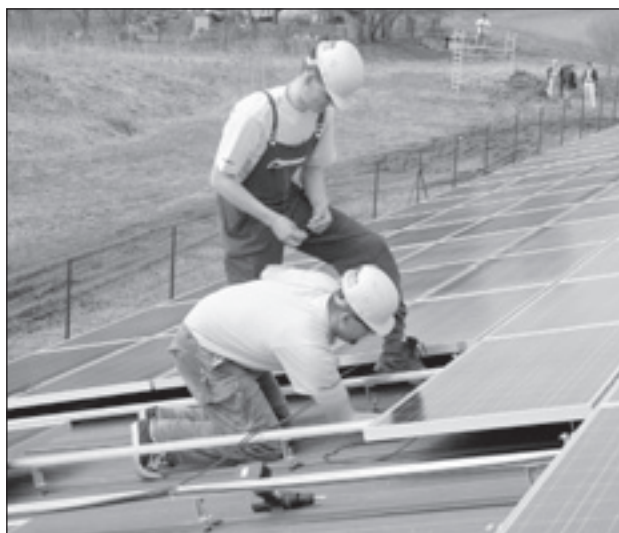
Montáž panelů na střeše objektu probíhala velice rychle
