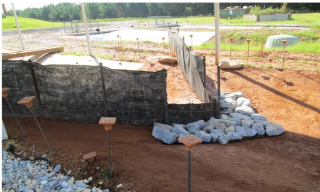
Obr. 8: Uměle vytvořený přeliv na textilií
