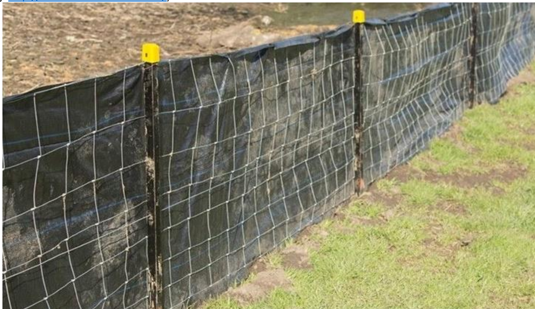
Obr. 5: Ukázka protierozní fólie doplněná o podporu z drátěné sítě
