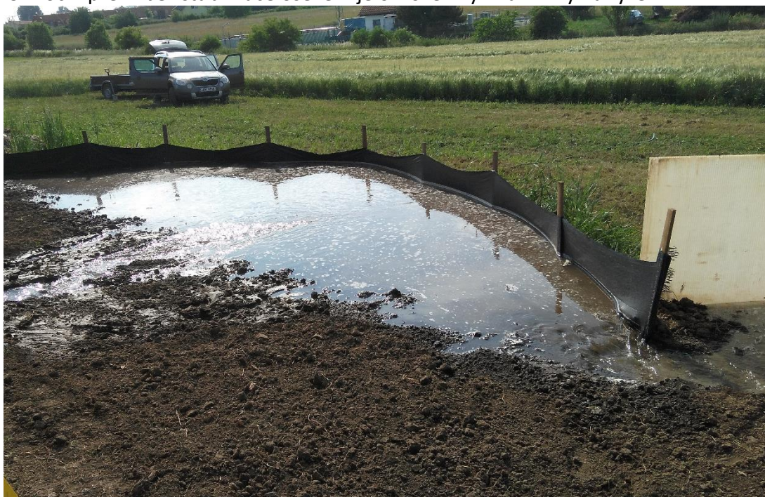
Obr. 9: Boční přeliv bez stabilizace osemem je ohrožen vymíláním rýh a rýžek
