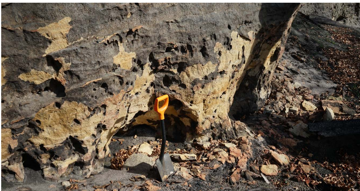
Obr. 38 Báze skalních výchozů byly často v důsledku hoření a hašení poškozené (z výskytu popílku na povrchu skal a ohořelého materiálu pod ležícími kameny lze usoudit na jejich stáří a přímou souvislost s požárem, např. N 50° 52.988', E 014° 18.057').
