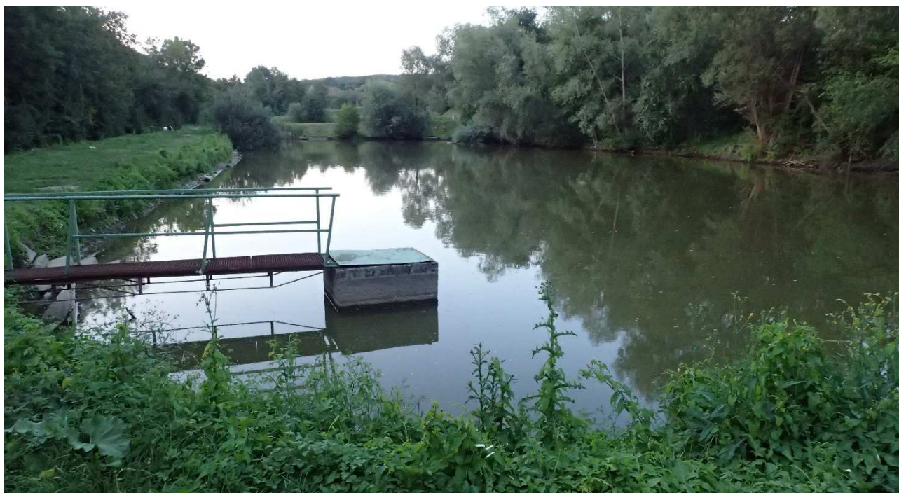
Obr. 12 – Příklad obtékané malé vodní nádrže (na toku Ovčírka u Rudic na Uherskobrodsku). Tok obtéká nádrž zleva, vlevo je patrná hráz nádrže.
