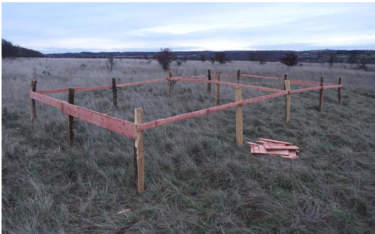
Obr. 31. Oplocenka pro trvalé fytoecologické plošky – varianta pro velké tury (a koně), 6 x 6 m – větší rozměry minimalizují vliv stínění snímkových ploch fošnami oplocení. Díky optické bariéře ve formě prken je není potřeba dále zviditelňovat. Oplocenky lze zpevnit dvěma řadami vysokopevnostního drátu (není zobrazeno), což lze doporučit na frekventovaných místech, zejména v případě oplocenek umístěných v aklimatizačních ohradách. V tomto případě byla volena možnost vyplocení obou sledovaných plošek zároveň – vhodné v situacích, kdy není možné plošky osnímkovat v roce 0 před zavedením pastvy (po osnímkování se jedna ploška zpřístupní odstraněním prken). Uspořádání navíc umožňuje jednotlivé plošky experimentálně dle potřeby z(ne)přístupňovat, což je plánováno i zde. Traviny, Benátky n. Jizerou. Foto © M. Jirků
