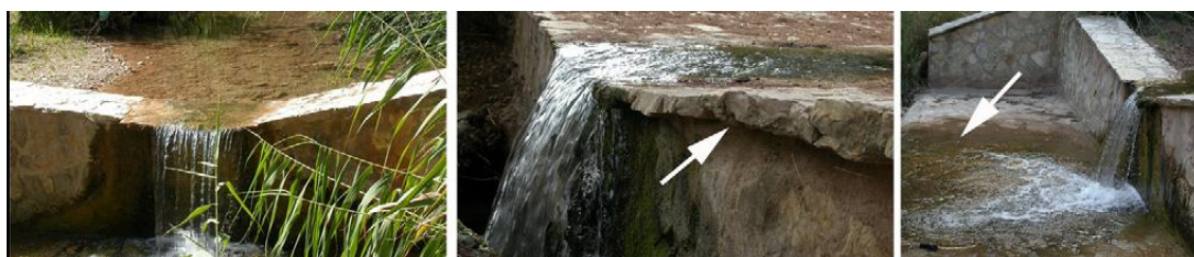
Obr. 36 Návrh koruny jezu zabraňující překonání překážky invazním rakem červeným (Dana et al. 2011).
